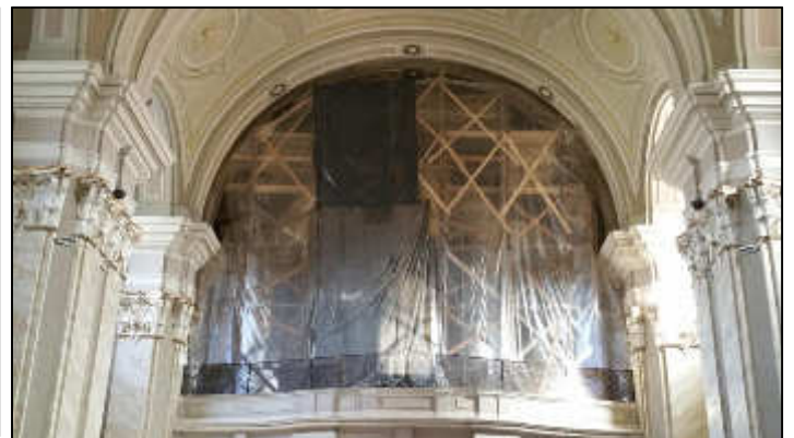
Am 2. August 2016 findet die Deutsche Wallfahrt nach Maria Radna statt. Zur Zeit wird die Decke der Orgelempore renoviert.
